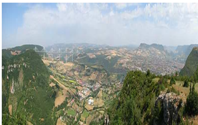
Viaduc de Millau
